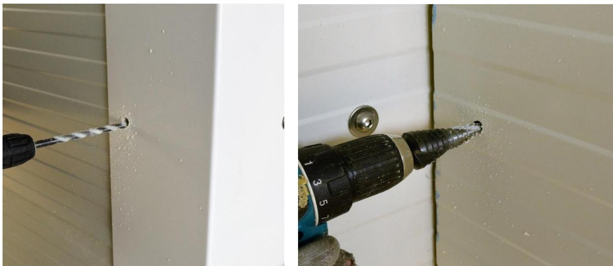
Présenter les assemblages manchon+rondelle+vis dans le trou de 15mm
