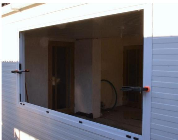
Emboitez le cadre et le contre-cadre et serrez avec des serres joints
