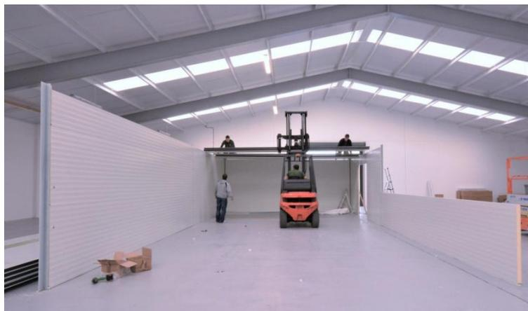
Les plaques de plafond sont posées sur les cloisons verticales
