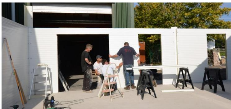
Assemblez les panneaux du milieu et bloquer l'articulation avec 2 U sur les cotés
