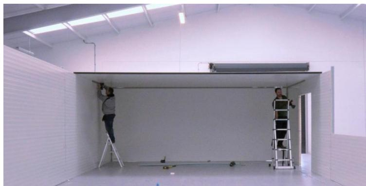
Vissez les angles PVC à l'intérieur pour maintenir le plafond en place et sécuriser les plaques
