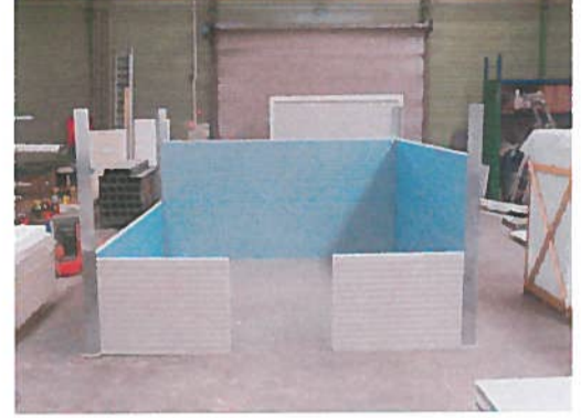
Étape 2 et 3 : Montage des panneaux et des équerres sur toutes les surfaces
