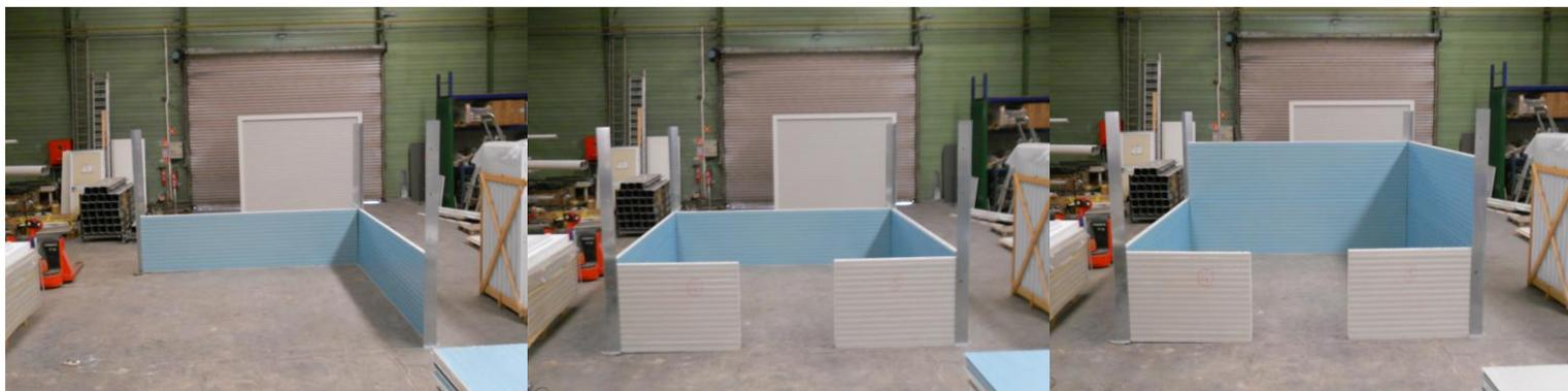
**1 Angle boulonné stabilise la structure**
