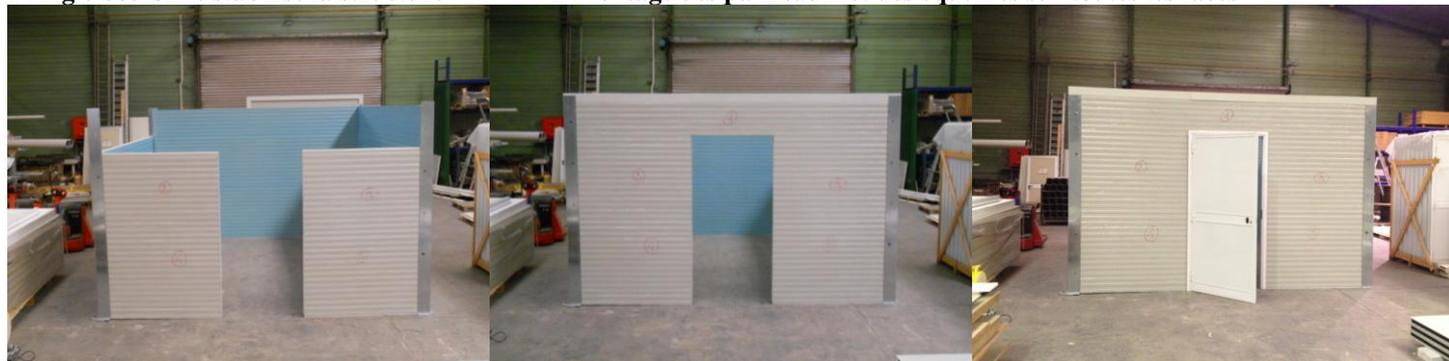
**3 Pose du plafond sur les cloisons en attente et pose des équerres d'habillage plafond**
