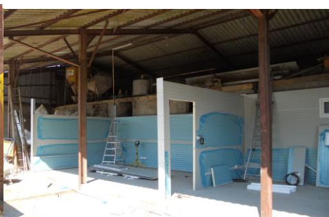
Panneaux pré découpés en montage
