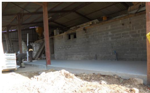
Dalle Béton en attente
