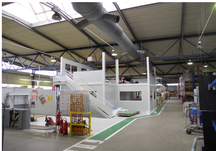
ISRI à Merckwiller (67) - 120m 2 de bureaux en cours de montage
