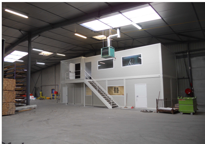
Hexacomb à Amboise (37) – 110m 2 de vestiaires, bureaux
